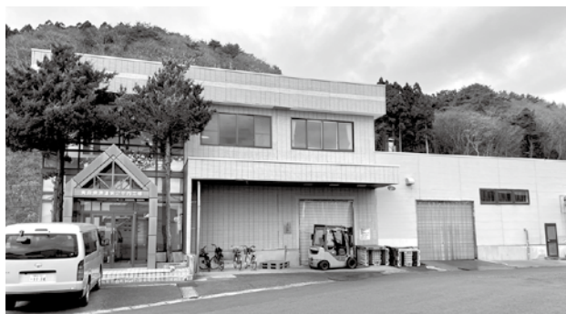
平内第二工場（平成5年～）
