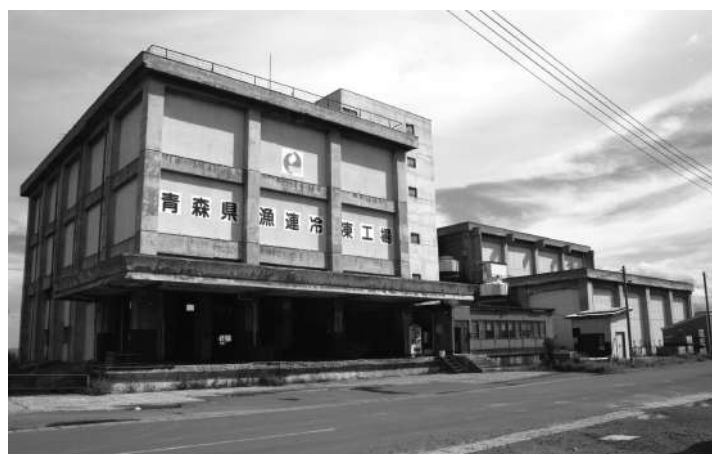
解体する港町製氷冷凍工場
